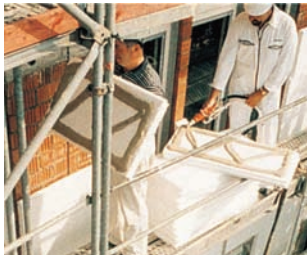
Нанесение клевого раствора
